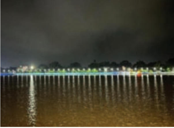
हाई मास्ट लाइट लगाया गया है। गया जी डैम के किनारे एलडी
